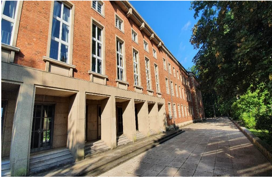
Abbildung 14: Außenansicht Niemannsweg 220 Quelle: LRH
